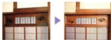
施工前 施工後
