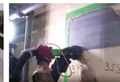
鋼板素地調整
