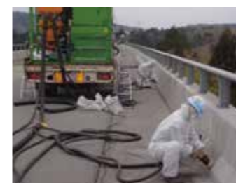
2人同時作業(橋梁高欄部の処理)
